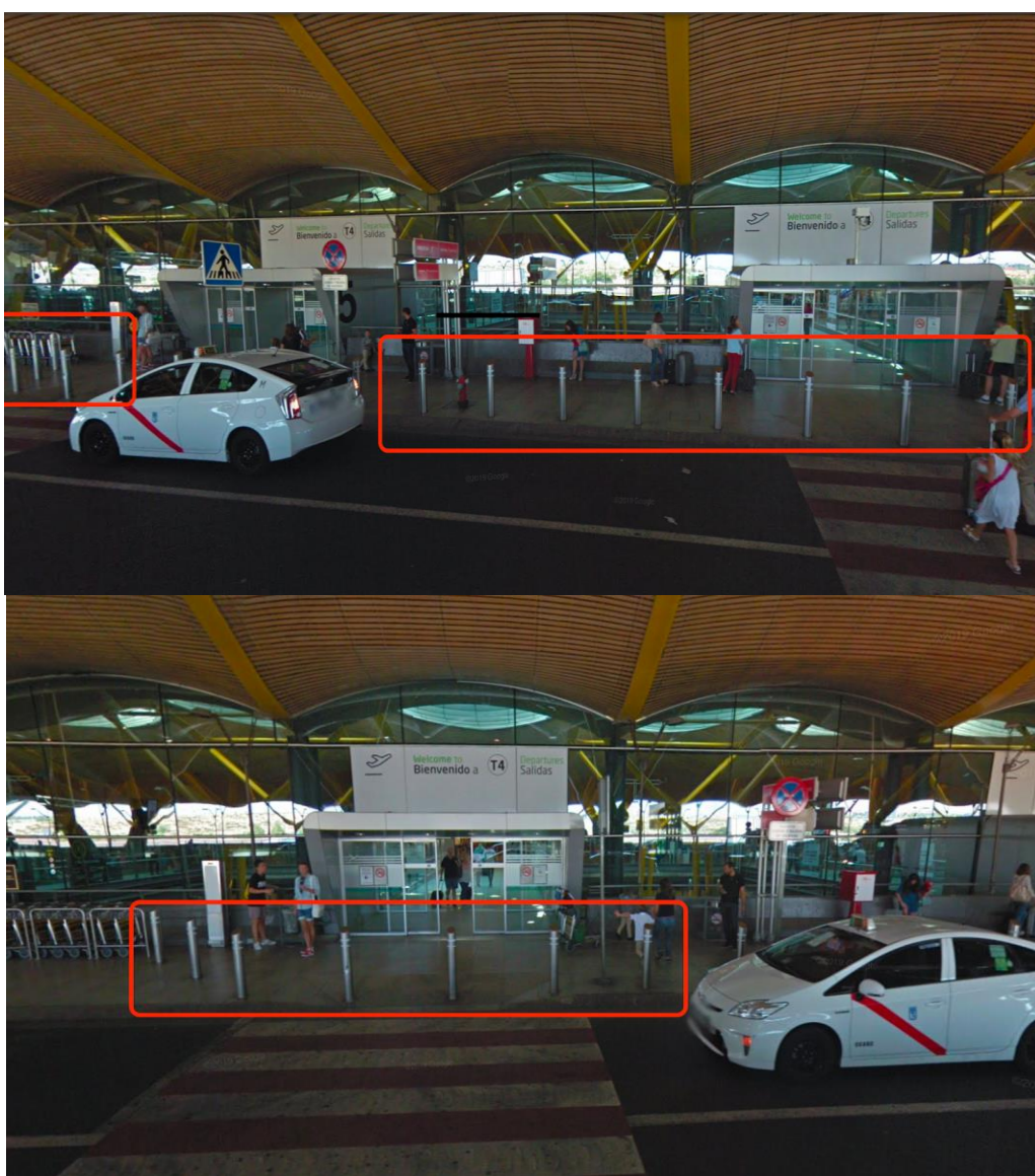
FIGURA 3: Bolardos Aeropuerto Adolfo Suárez Madrid-Barajas, Terminal 4.
