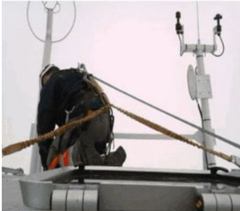
Figura 8. Realizando trabajo encima de la nacelle o góndola. [1]
