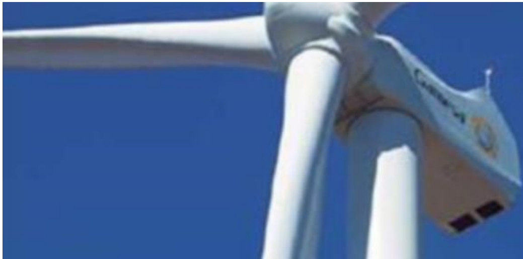
Figura 33: Torre tubular mixta (acero y hormigón). Fuente: Curso 2021-2022 Energías Renovables.
