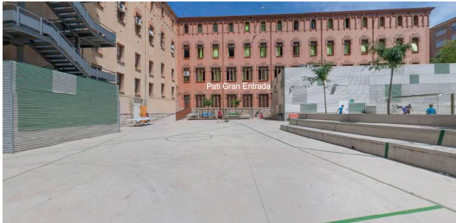
Foto del patio de entrada
