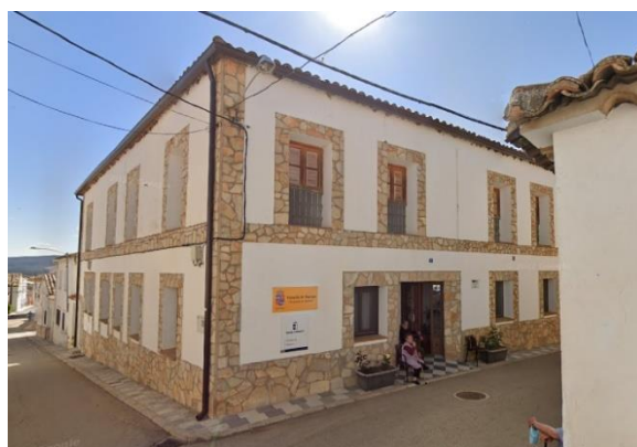
Ilustración 26: Edificio del Salón de Actos. Fuente: (Elaboración Propia)
