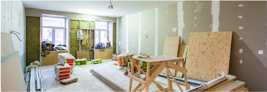
Ilustración 9: Rehabilitación de un edificio por el interior. Fuente: (www.blog.energygo.es, 2022)
