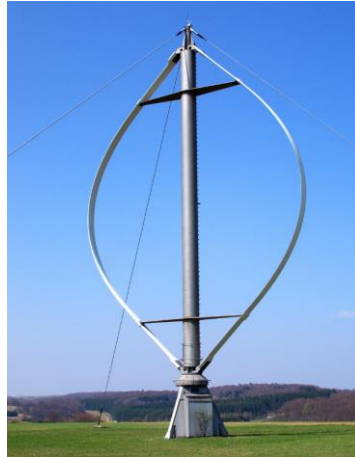
Figura 19: Turbina Darrieus
