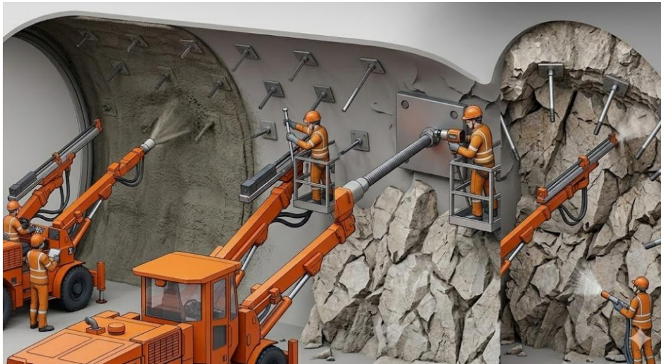
Figura 36. Proceso de bulonado de hastial y bóveda del túnel. Fuente: Elaboración propia.
