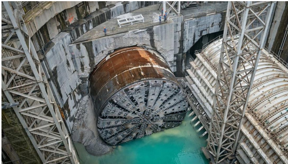
Figura 7. Tuneladora S-880. Fuente: Xataka. (2023)
