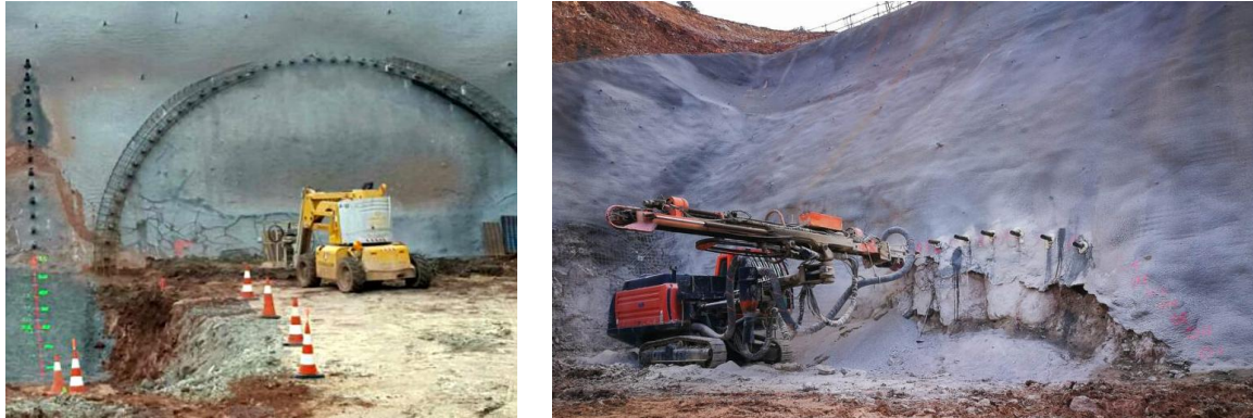
Figura 38. Proceso constructivo del paraguas de micropilotes. Fuente: OSEBE S.A. (s.f.).
