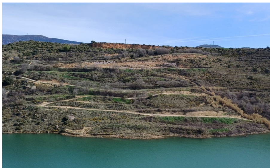
Ilustración 42. Vista general de la ladera desde la orilla contraria. Elaboración propia
