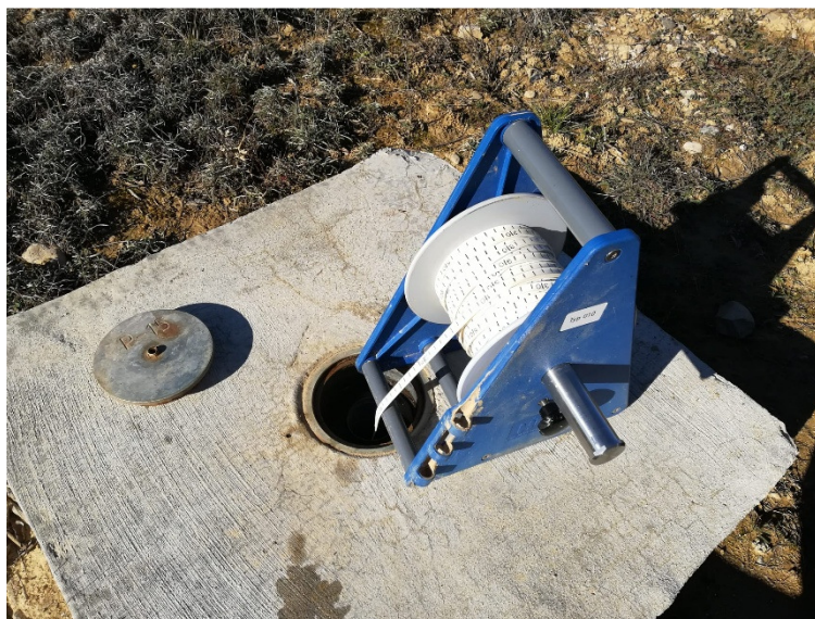
Ilustración 22. Sondeo de medición para piezometría abierta. Fuente: PROESZA, S.L. (Elaboración propia)
