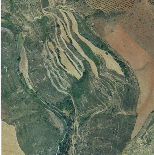
Ilustración 43. Ortofoto de la zona del deslizamiento. Fuente: PNOA
