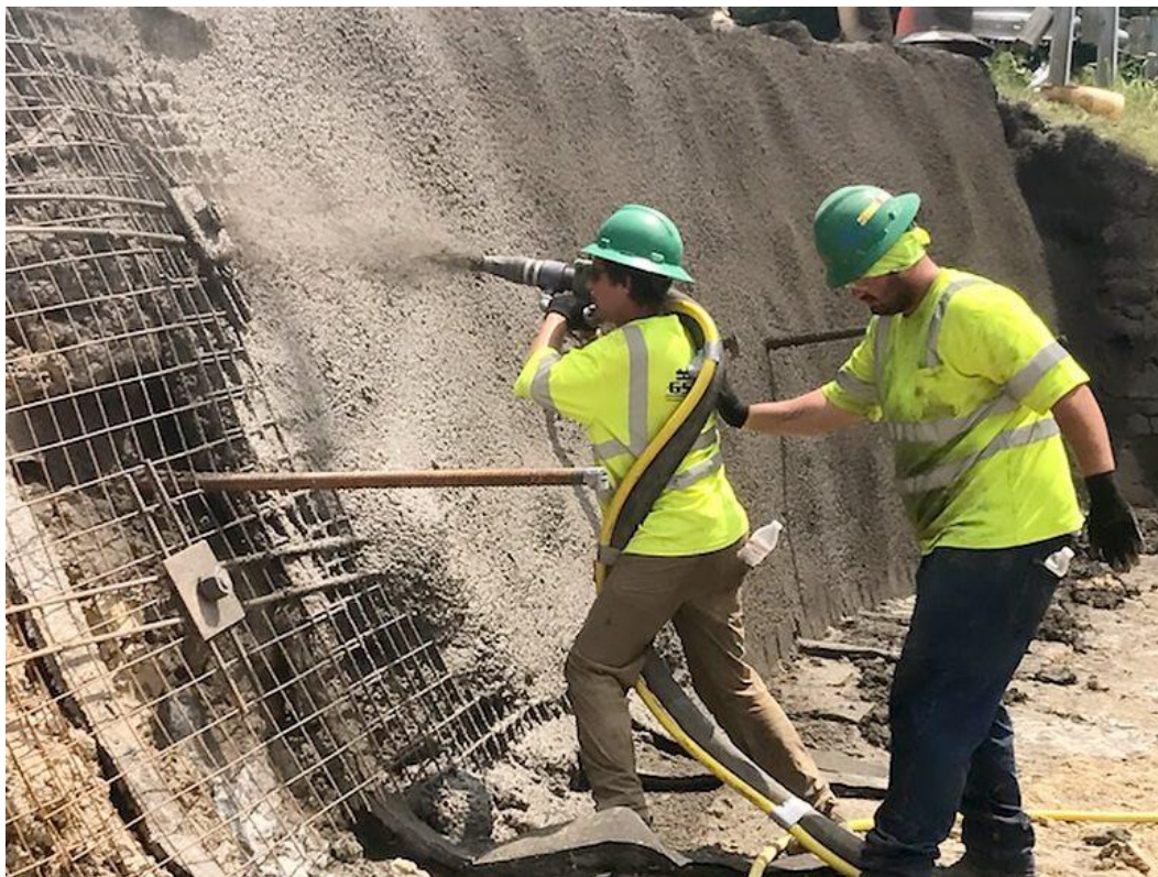
Figura 53: Operarios gunitando el frente de excavación de la primera bancada (Fuente: Catálogo de Geostabilization)
