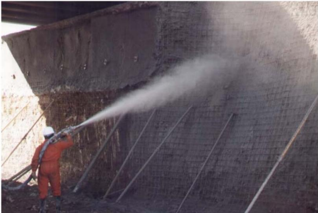
Figura 33: Operario proyectando hormigón sobre paramento armado con mallazo y previamente bulonado (Fuente: Auscultación y corrección de inestabilidad de taludes de carreteras y ferrocarriles. CLAVETEADO DEL TERRENO (Ortuño, 2010))
