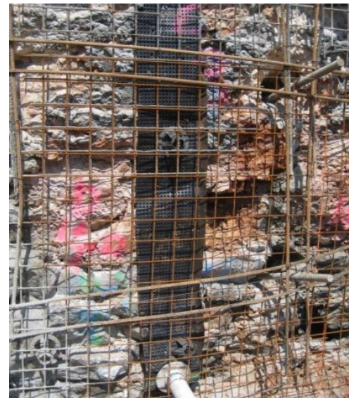
Figura 49: Banda drenante con salida al exterior del paramento (Fuente: Soil Nail Walls – Reference Manual (FHWA, 2015))
