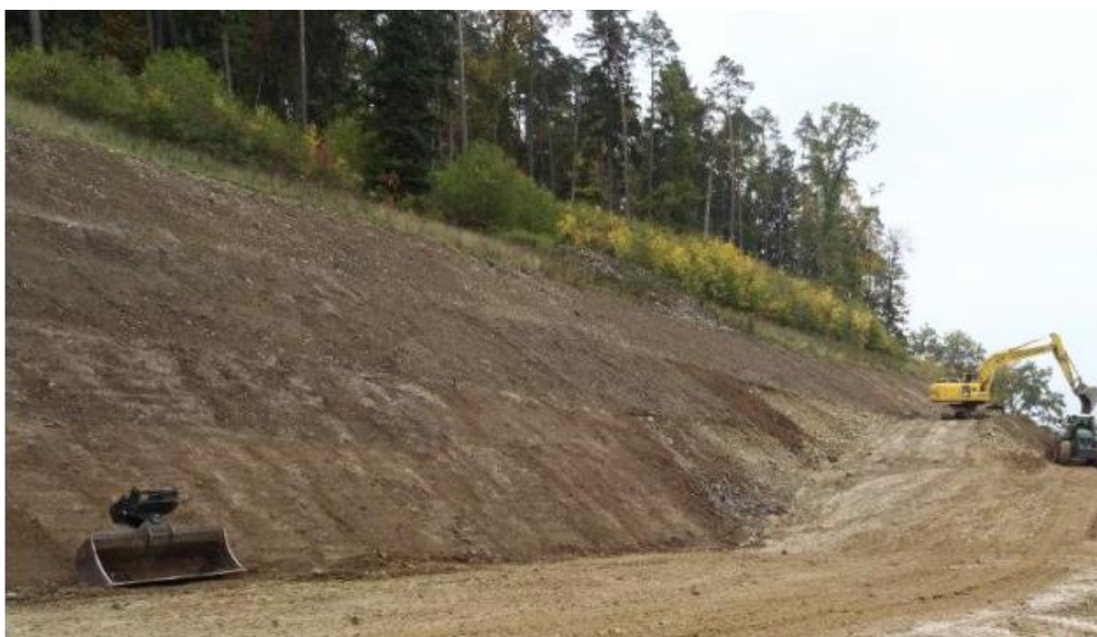
Figura 3: Talud excavado mediante retroexcavadora (Fuente: Slopes and Excavations (Wietek, 2022))
