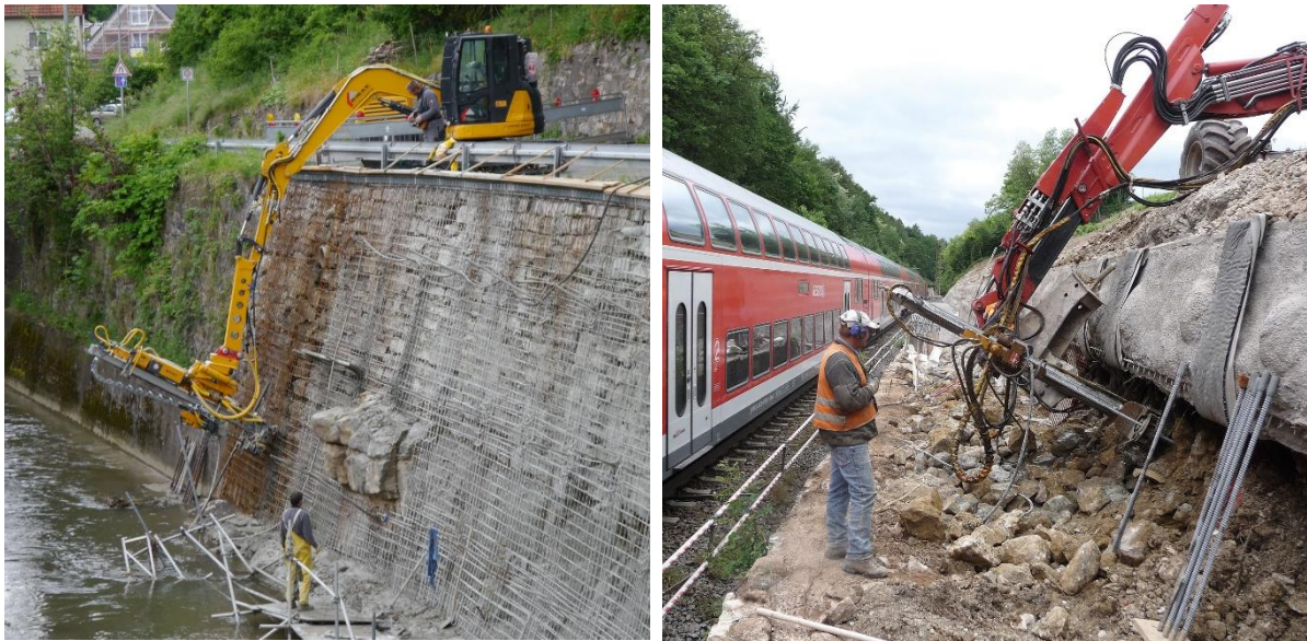
Figura 43: Ejecución de muros de soil nailing en situaciones comprometidas (Fuente: Catálogo de Titan Ischebeck)
