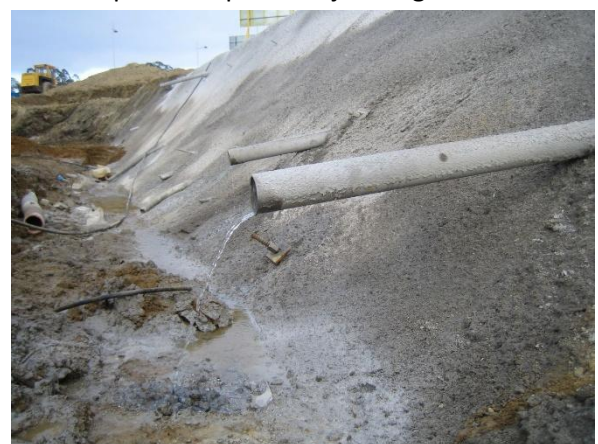
Figura 52: Dren californiano evacuando en muro de suelo claveteado (Fuente: Catálogo de Civogal)
