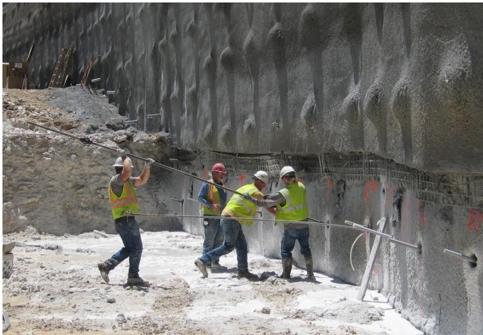
Figura 47: Operarios introduciendo bulones en perforaciones previamente realizadas sobre un frente de excavación pregunitado (Fuente: Soil Nail Walls – Reference Manual ((FHWA, 2015))
