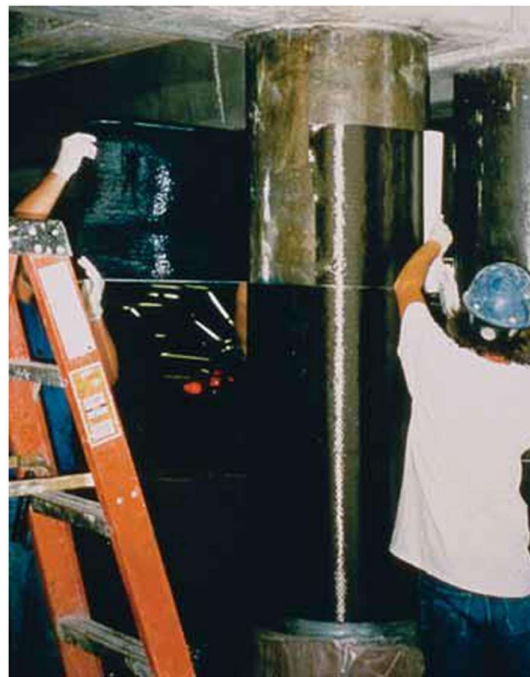
Figura 31 Presentación y aplicación de los tejidos de fibra de carbono (Lopez, 2012)
