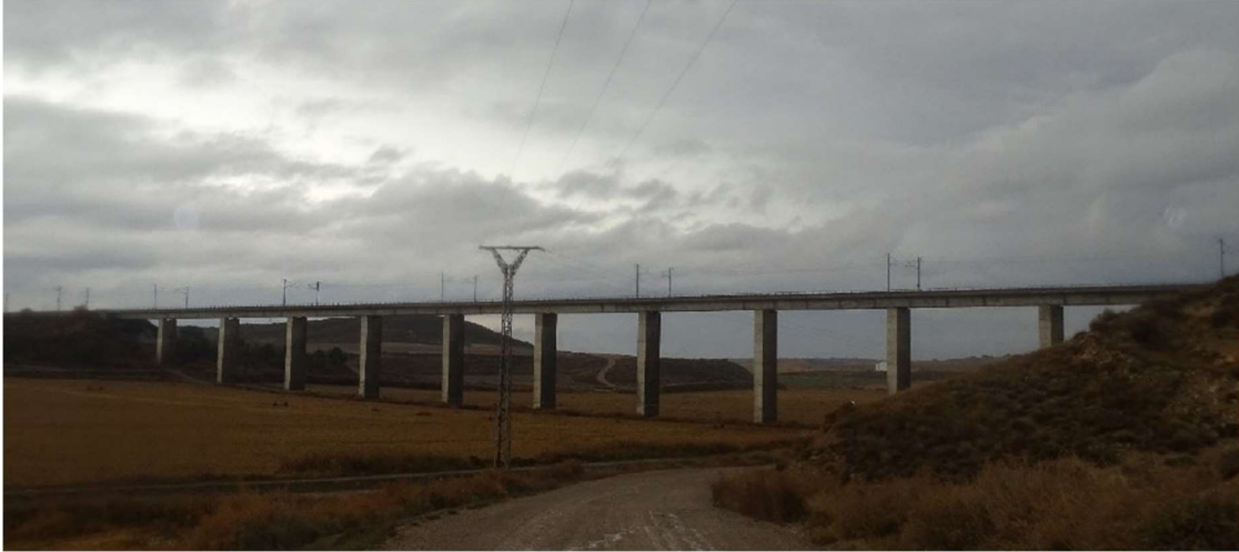
Figura 3 Viaducto Val de Castejón, en Peñalba – Huesca (Fernandez A. , 2023)
