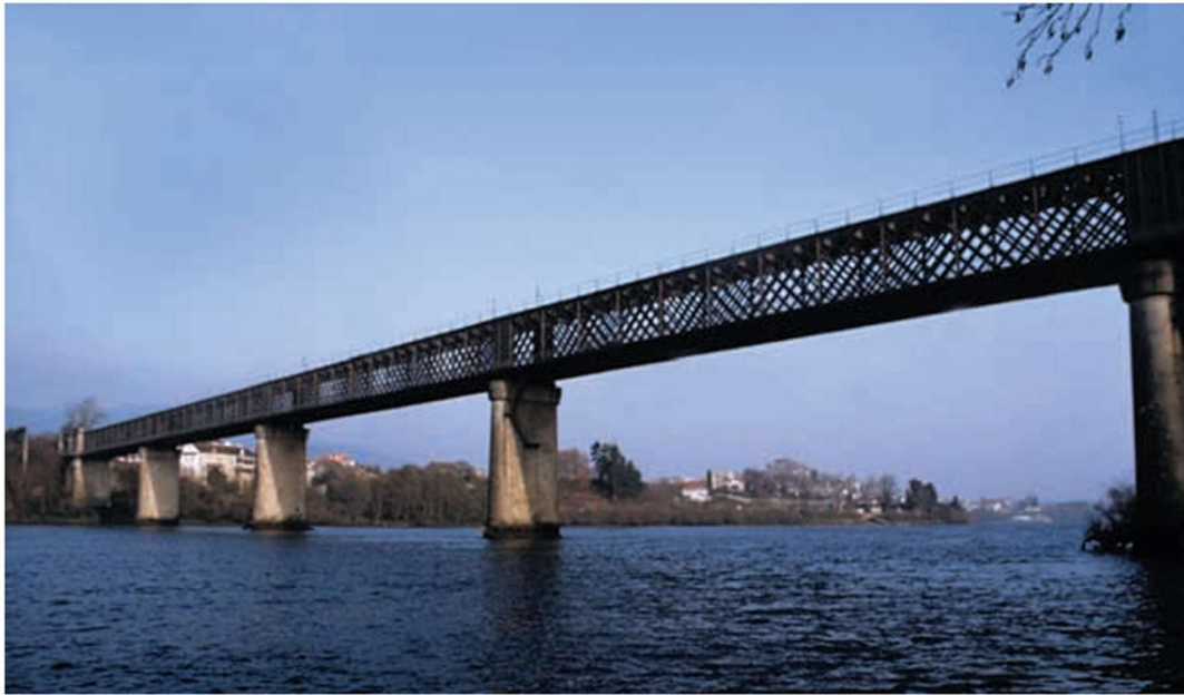
Figura 2 Puente Internacional de Tuy sobre el río Miño, de tipo celosía (Silva, 2011)
