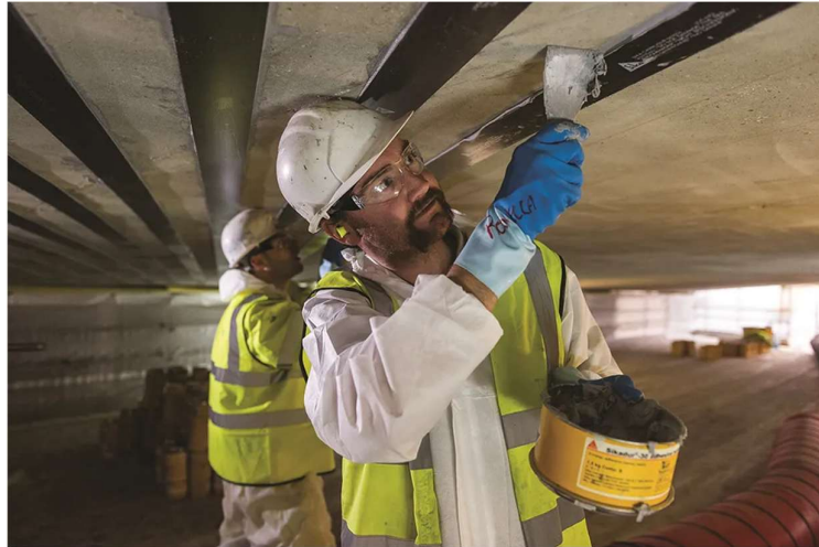
Figura 32 Aplicación de adhesivo estructural en refuerzo FRP (SIKA, 2025)
