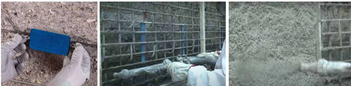
Figura 27 Colocación de ánodo de sacrificio para posterior aplicación de mortero de reparación sobre la zona (Andrade, Ortin, Soldevila, & Orte, 2024)
