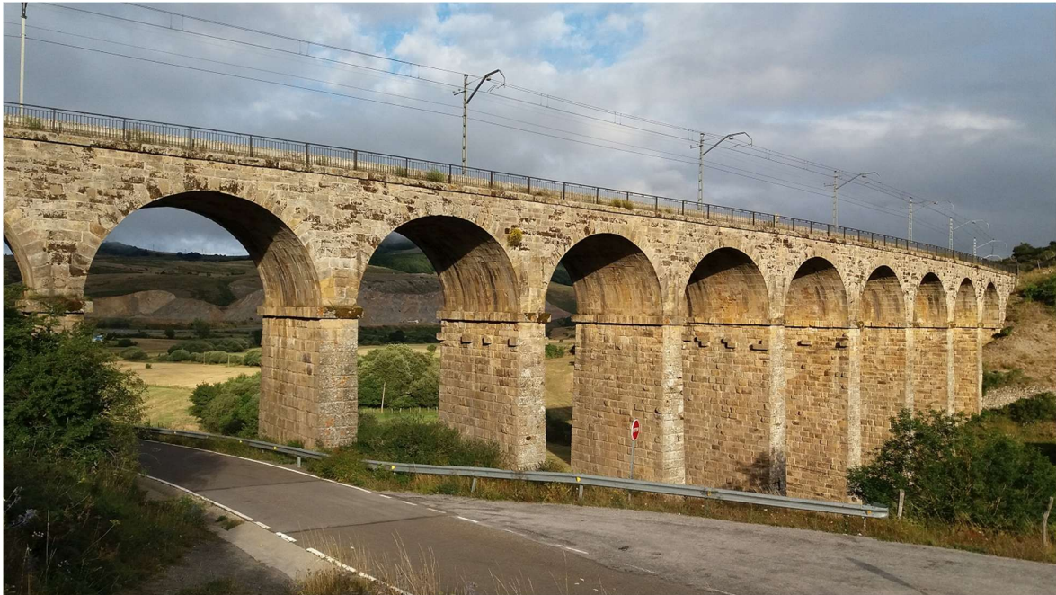
Figura 1 Puente de fábrica línea Santander - Reinosa, Viaducto de Celada (Ministerio de Transportes y Movilidad Sostenible, ADIF, 2022)
