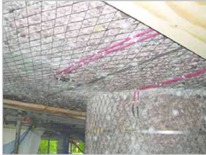
Figura 29 Detalle de la instalación de ánodos de corriente impresa tipo malla en un pilar y viga antes de la aplicación del mortero de reparación (Andrade, Ortin, Soldevila, & Orte, 2024)
