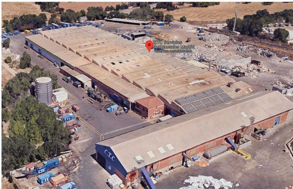
Ilustración 16. Foto 3D de la cubierta elegida para el montaje de los paneles
