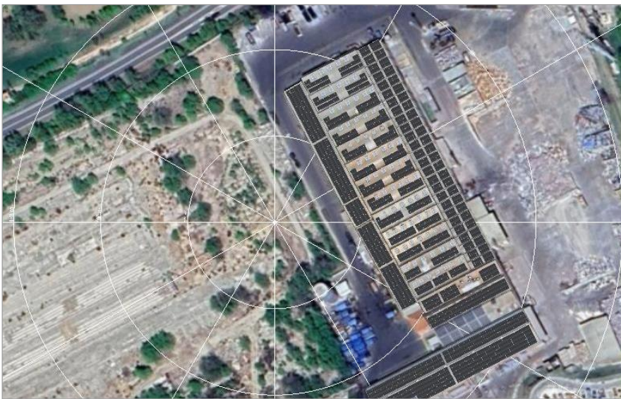
Ilustración 18. Vista de la planta Fotovoltaica instalada en la cubierta
