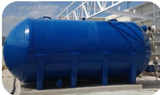
Figura 3-9. Filtro multicapa.
