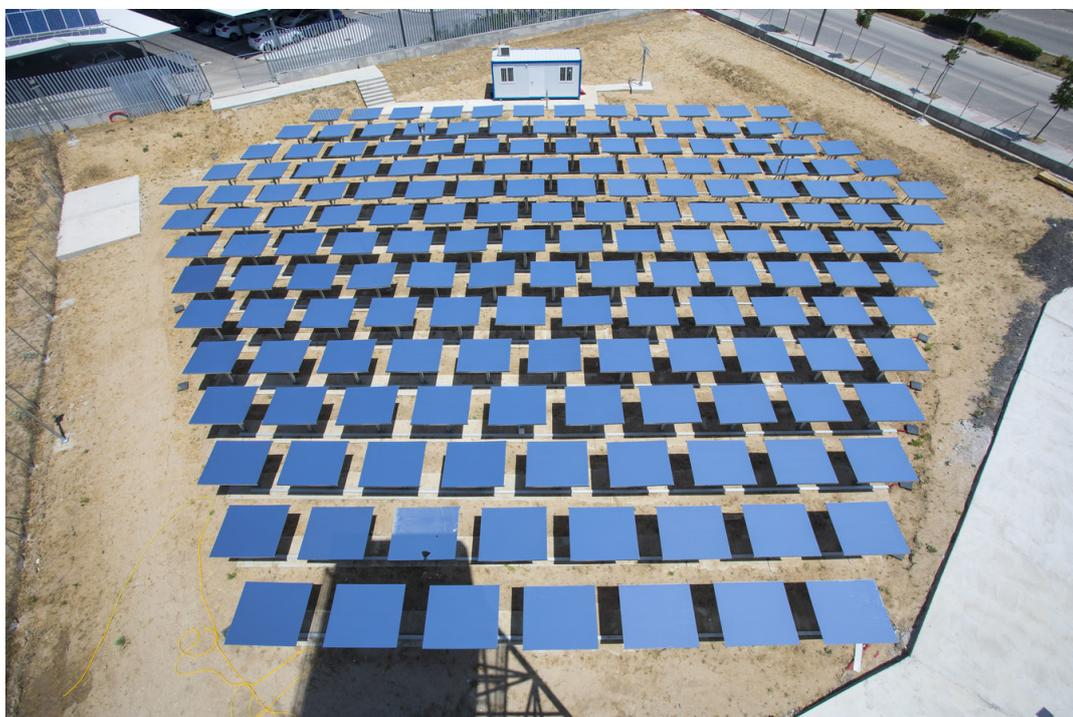
Figura 5.4: Espejos heliostáticos IMDEA [21]
