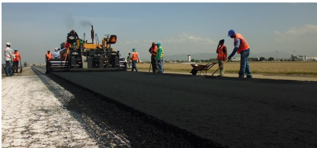
Figura 28: Operarios trabajando en el asfaltado de una pista de aterrizaje en Latinoamérica
