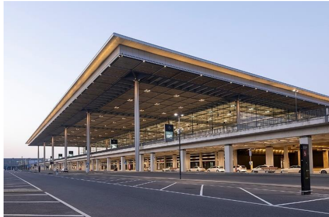
Figura 36: Terminal del aeropuerto de Berlin-Brandeburgo completamente vacía
