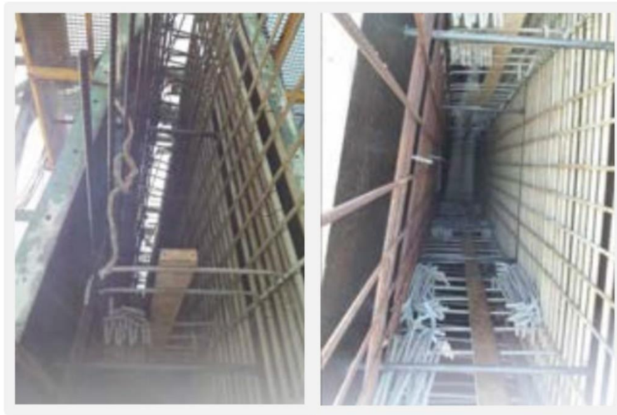
Figura 17. Detalle de armados con solución mixta acero-PRFV en puerto de Escombreras. (Autoridad Portuaria de Cartagena. APC)
