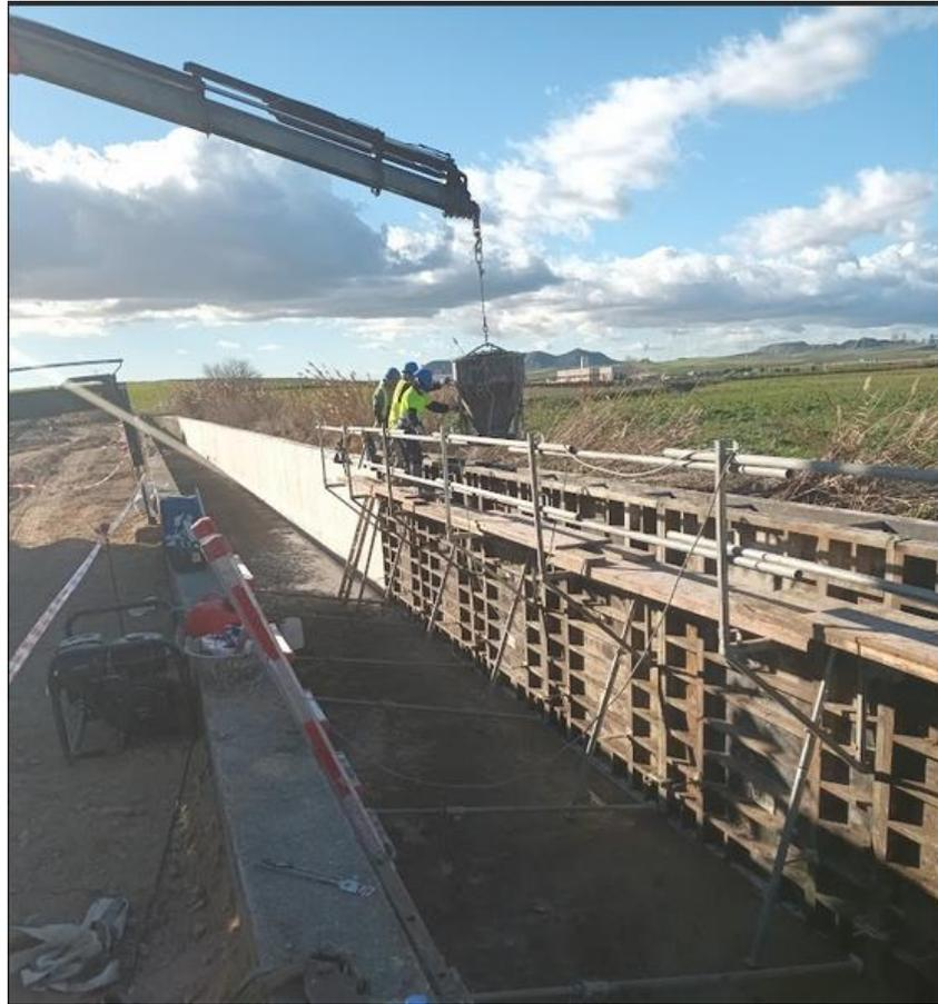
Ilustración 28. Reconstrucción de canal (Fuente: elaboración propia)
