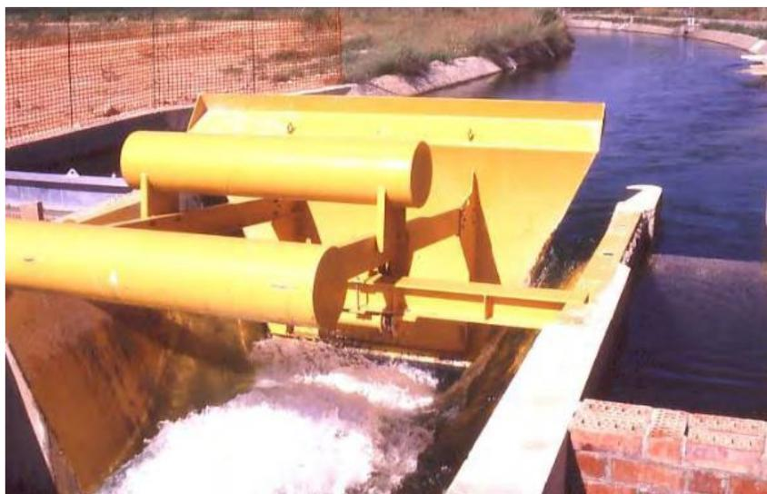
Ilustración 30. Compuertas de nivel constante (Fuente: elaboración propia)
