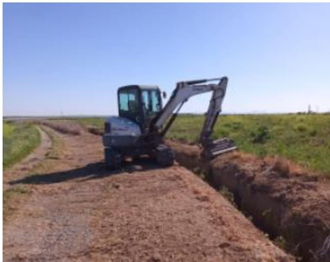
Ilustración 24. Desbroce por medios mecánicos del canal (Fuente: elaboración propia)
