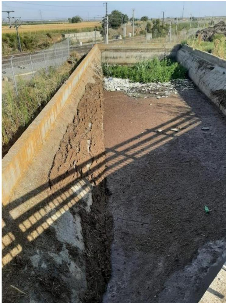
Ilustración 15. Obstrucción en canal (Fuente: elaboración propia)
