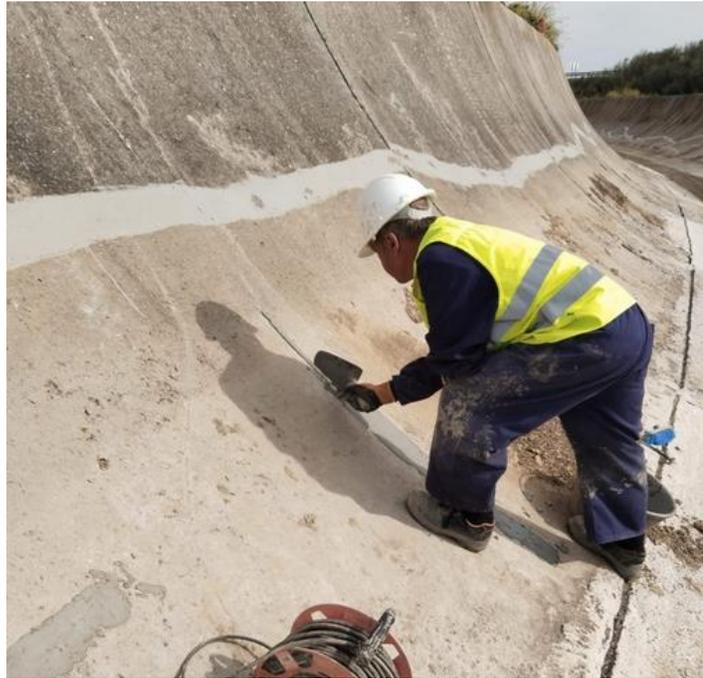
Ilustración 27. Reparación de grietas del canal (Fuente: elaboración propia)
