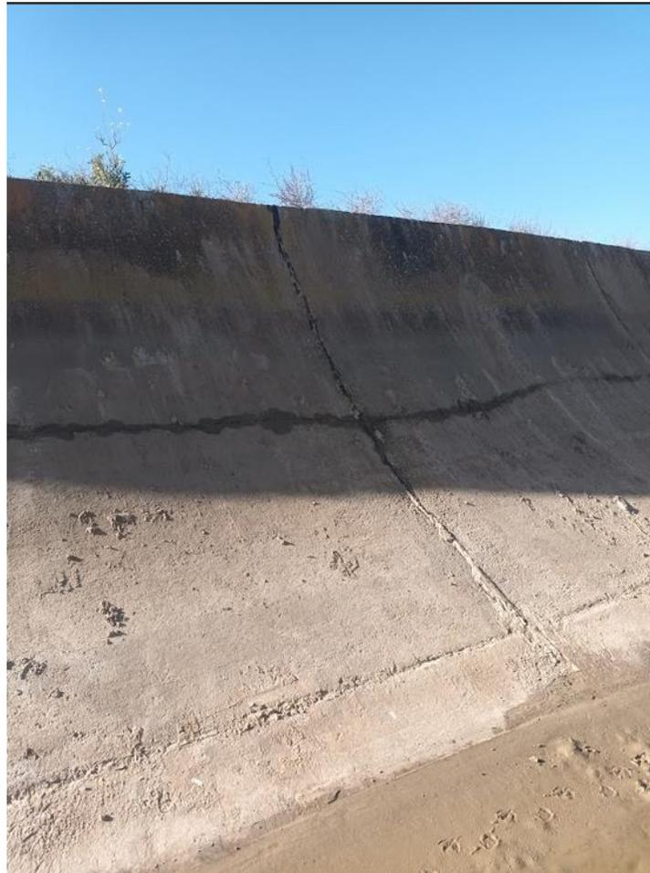
Ilustración 19. Fisuras en canal (Fuente: elaboración propia)
