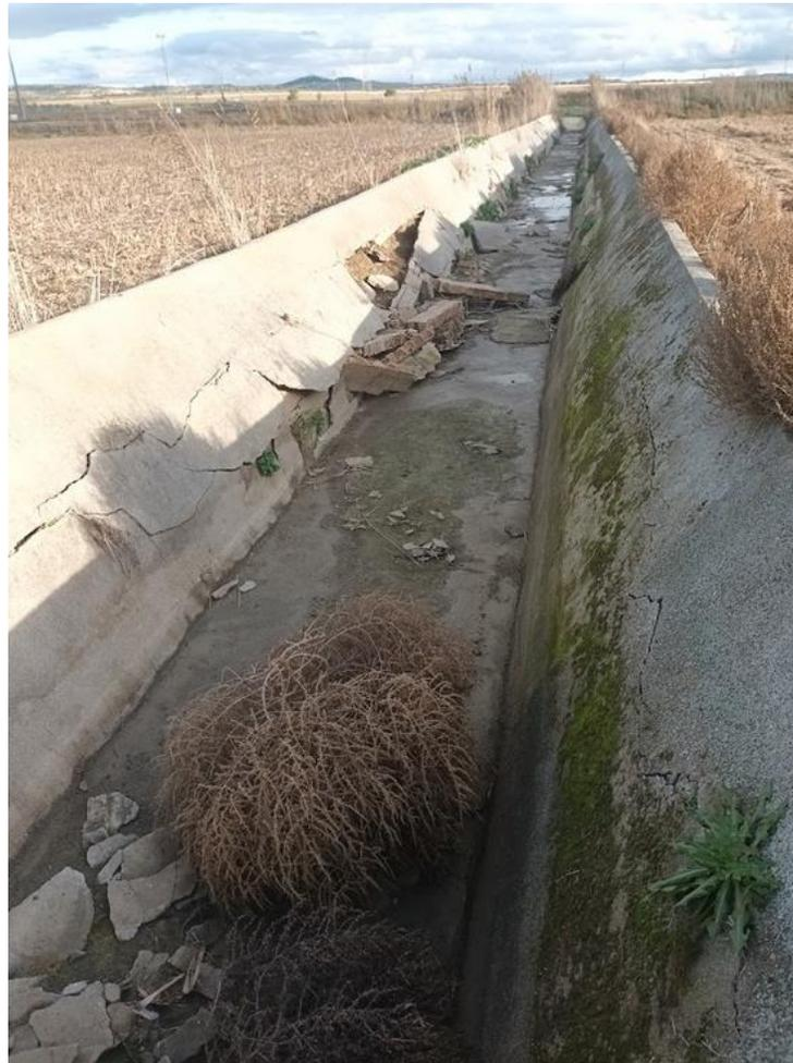
Ilustración 20. Rotura de canal (Fuente: elaboración propia)
