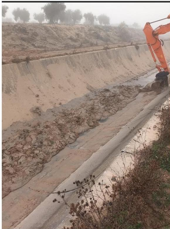
Ilustración 23. Limpieza de lodos (Fuente: elaboración propia)
