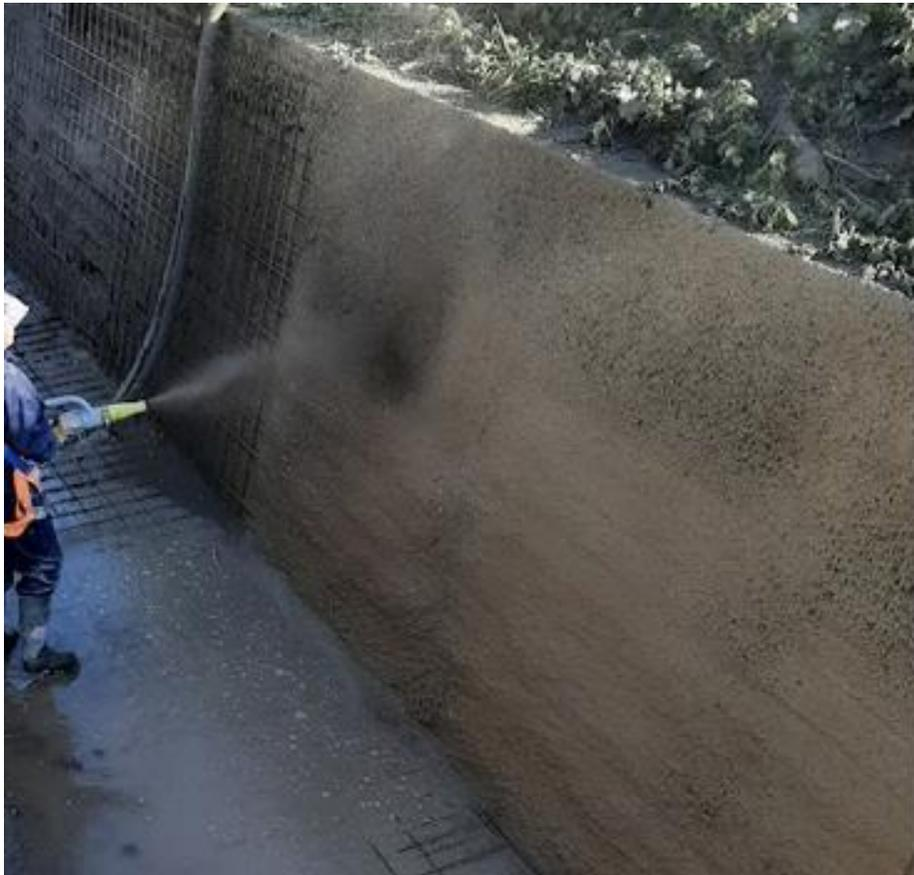
Ilustración 25. Trabajos de revestimiento en canal (Fuente: elaboración propia)
