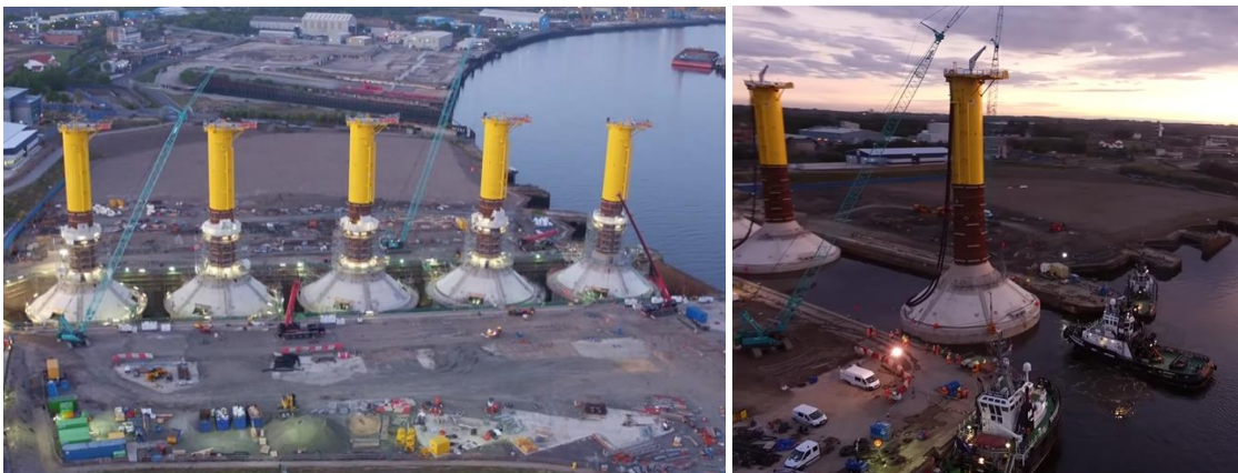
Figura 9. Fabricación en dique seco y remolcado mediante barco (Parque eólico de Blyth; https://www.bamnuttall.co.uk/ )
