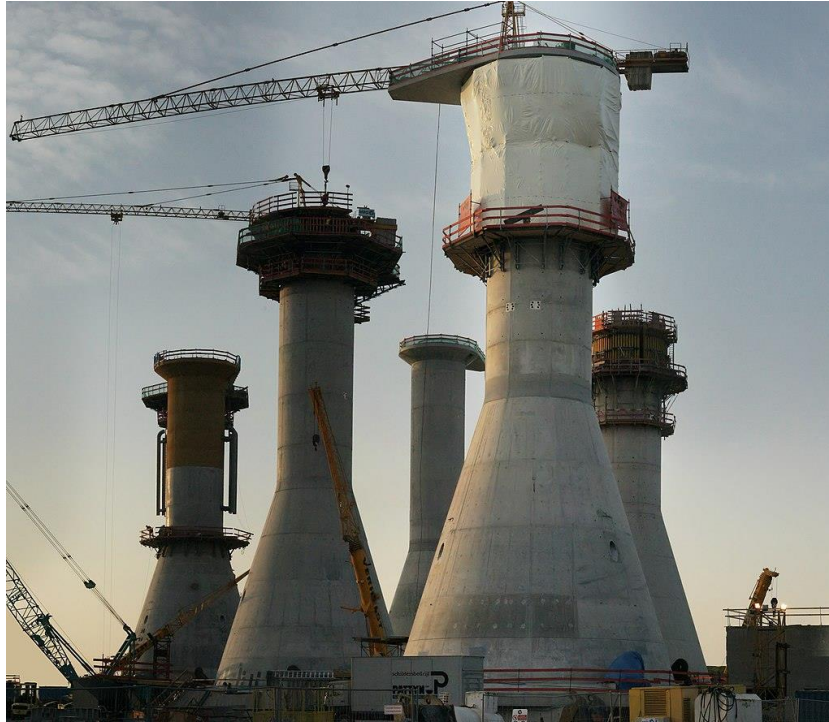
Figura 19. Construcción de cimentaciones de gravedad en el parque eólico Thorntonbank I (Wikimedia)
