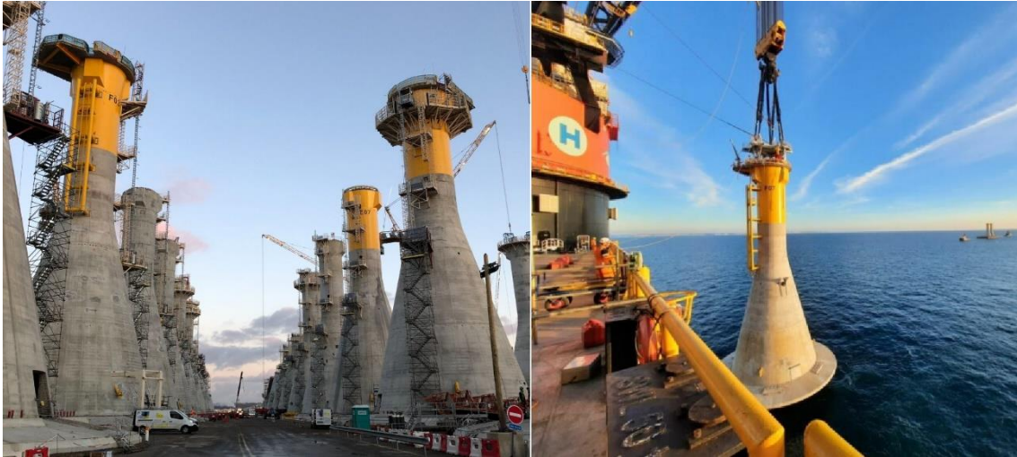
Figura 13. Cimentación de cajones tronco-conicas
