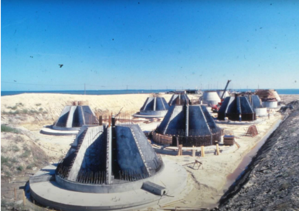
Figura 15. Construcción de cimentaciones del parque eólico de Vindeby ( www.orsted.com )
