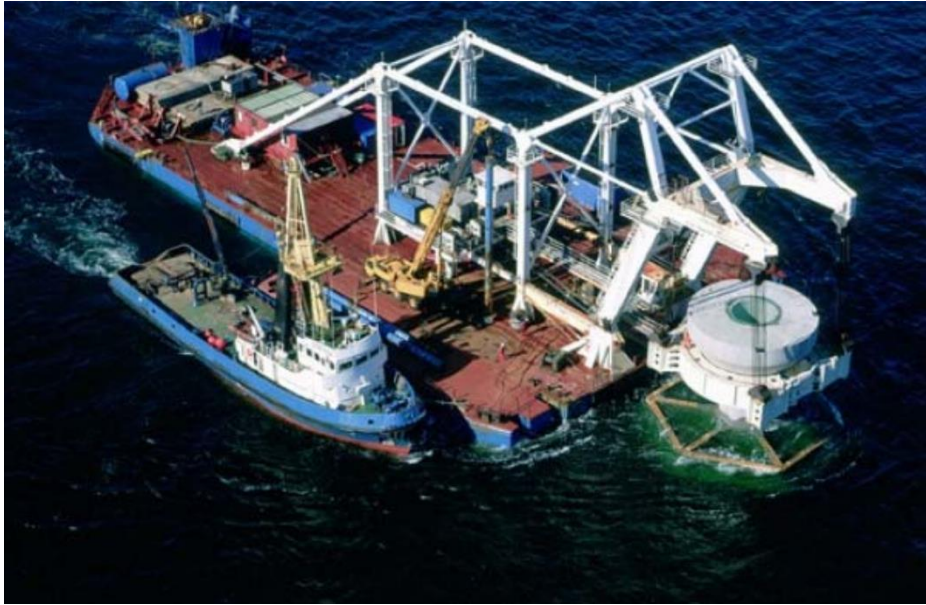
Figura 17. Instalación de cimentación en el parque eólico de Nysted I (SBM Offshore)
