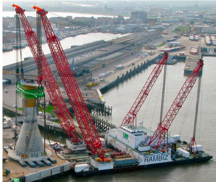
Figura 8. Carga de cimentación de gravedad en Thorntonbank (Scaldis, 2018; www.maritimejournal.com )
