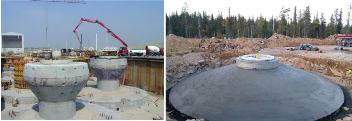
Figura 11. Izquierda: Cimentación de gravedad del parque eólico de Middelgrunden (Sorensen y Chozas, 2021). Derecha: Parque eólico Lehtirova ( www.coydegroupp.com )
