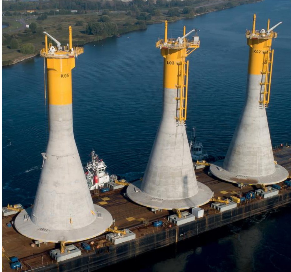
Figura 20. Acopio de cimentaciones en dique, parque eólico de Fécamp ( www.saipem.com )
