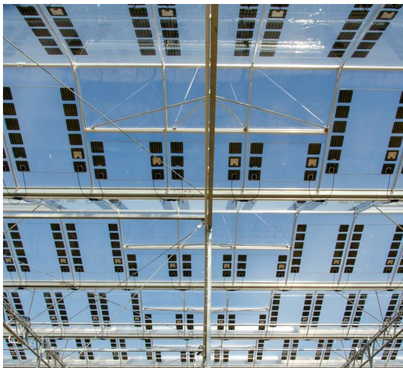
Ilustración 13 - Techo solar con módulo agro fotovoltaicos (Fuente: BriteSolar)
