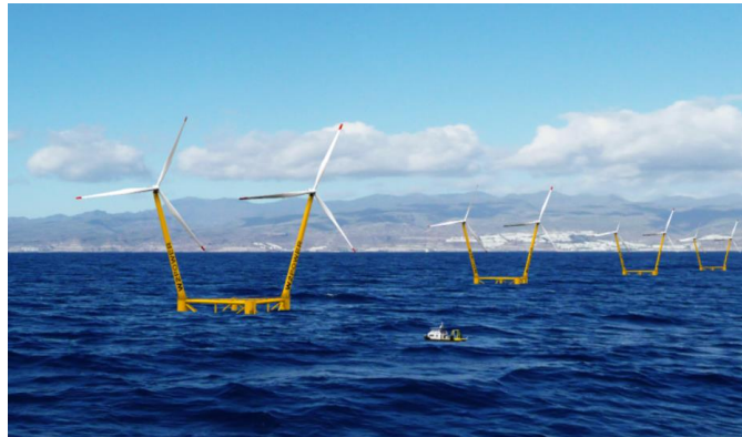
Ilustración 13: Reducción de espacio entre rotores y correcta orientación de las plataformas[26]
