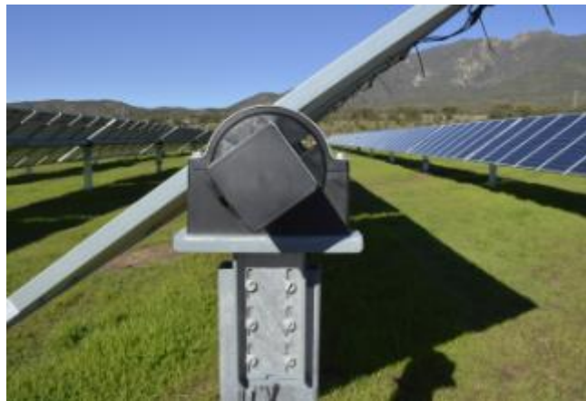
Figura 3: Ejemplo de sistema de orientación a 1 eje.
