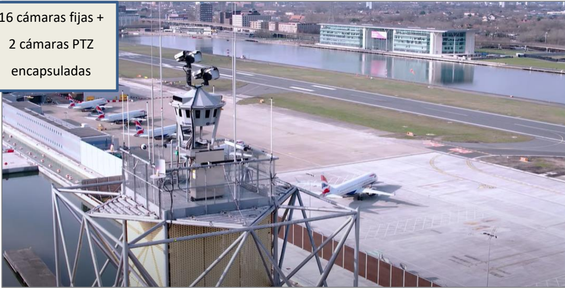
Ilustración 10. Array de cámaras fijas visión 360º y cámaras PTZ giratorias. Aeropuerto de London City
