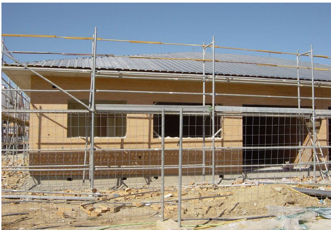
Figura 17. Huecos de ventanas con envolvente cerrada.
