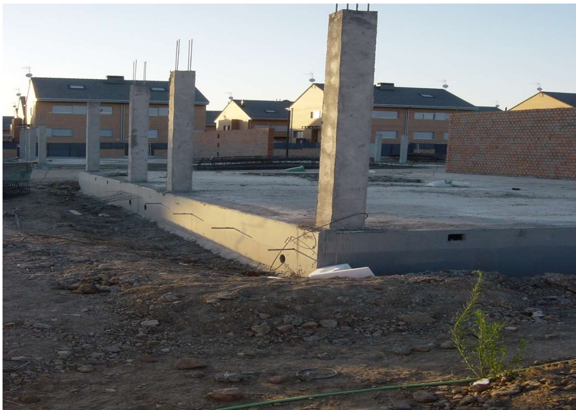
Figura 12. Detalle de los pilares y muro de carga de la vivienda.
