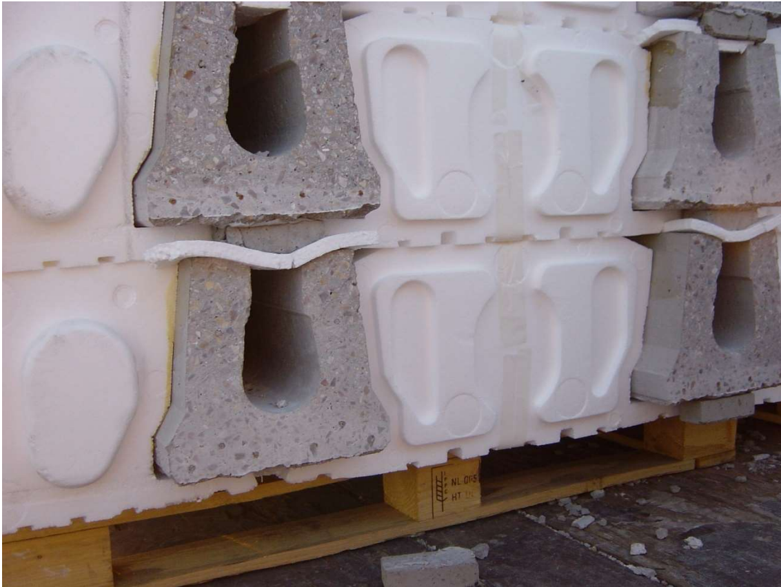
Figura 14. Viguetas del forjado de planta inferior y superior con bovedilla de polietileno extruido.
