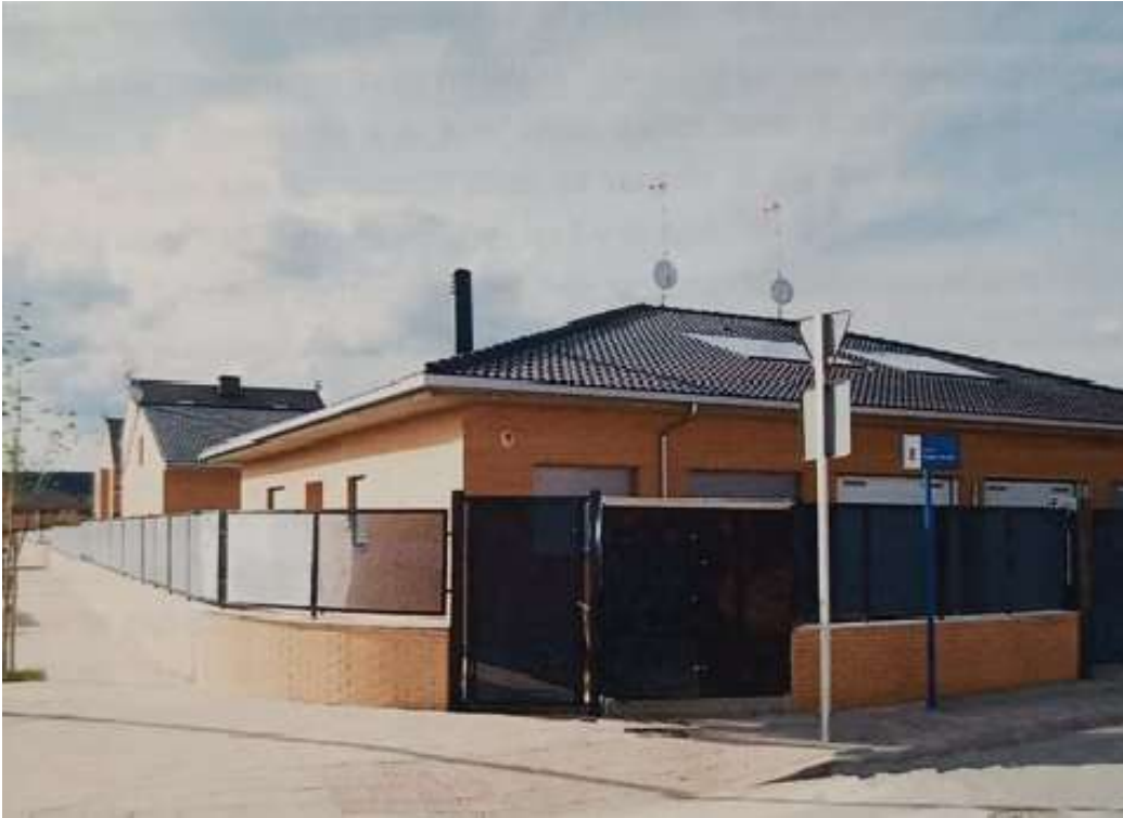
Figura 6. Fachada anterior de la vivienda.
