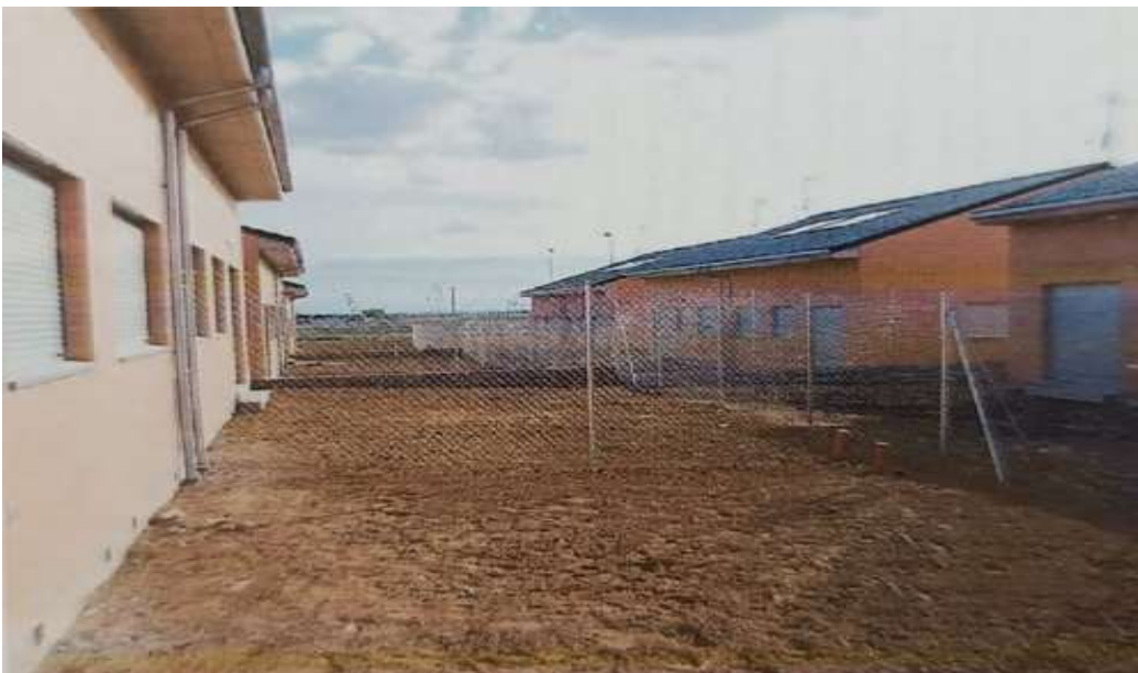
Figura 7. Fachada posterior de la vivienda.
