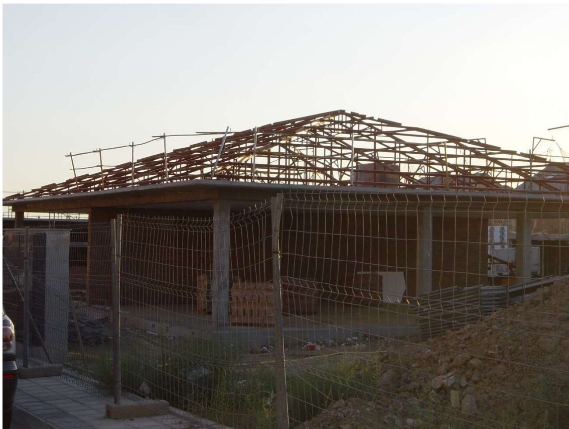
Figura 16. Estructura de tejado.
