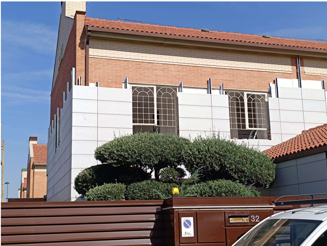
Figura 87. Instalación de SATE con revestimiento de paneles en vivienda unifamiliar.
