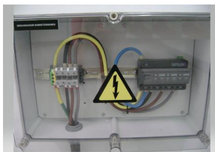
Ilustración 45. Descargador de sobretensiones
